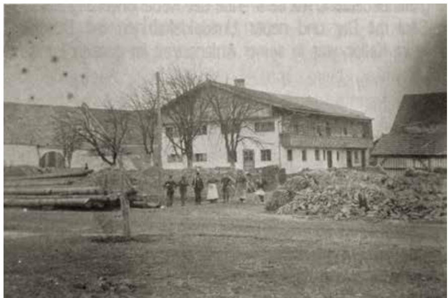
Das alte Karpfingerhaus unmittelbar vor dem Abriss 1909
