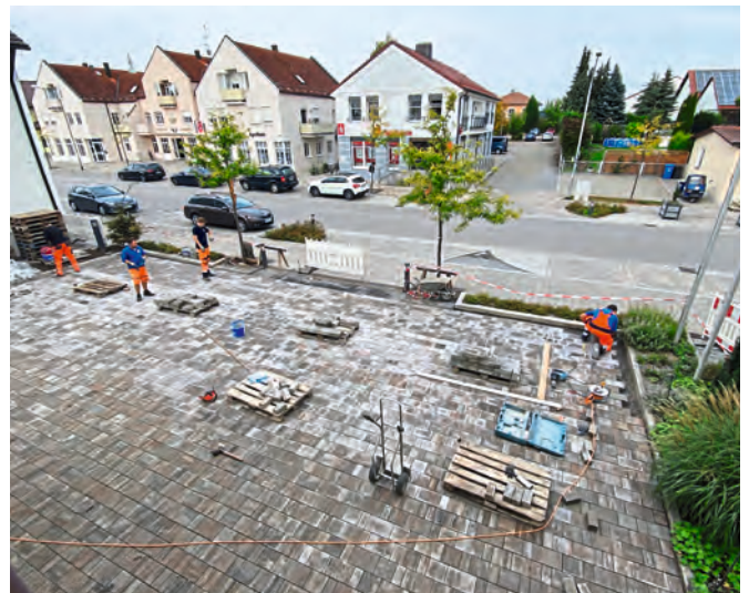
Pflasterarbeiten Parkplatz Rathaus Aiterhofen
