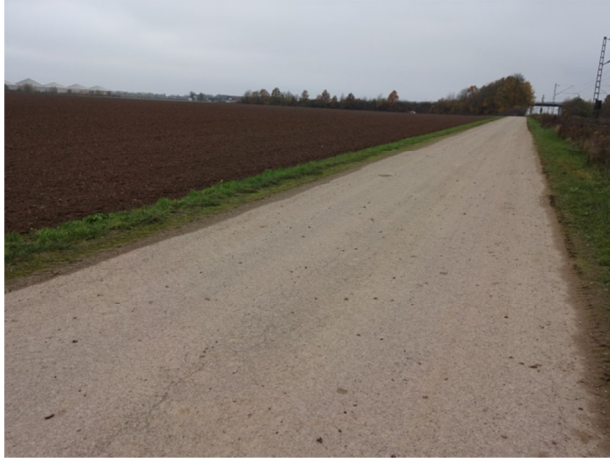
Blick vom nördlichen Wirtschaftsweg Richtung Westen zur GVS Amselfinger Straße (gepl. Anlage links)
